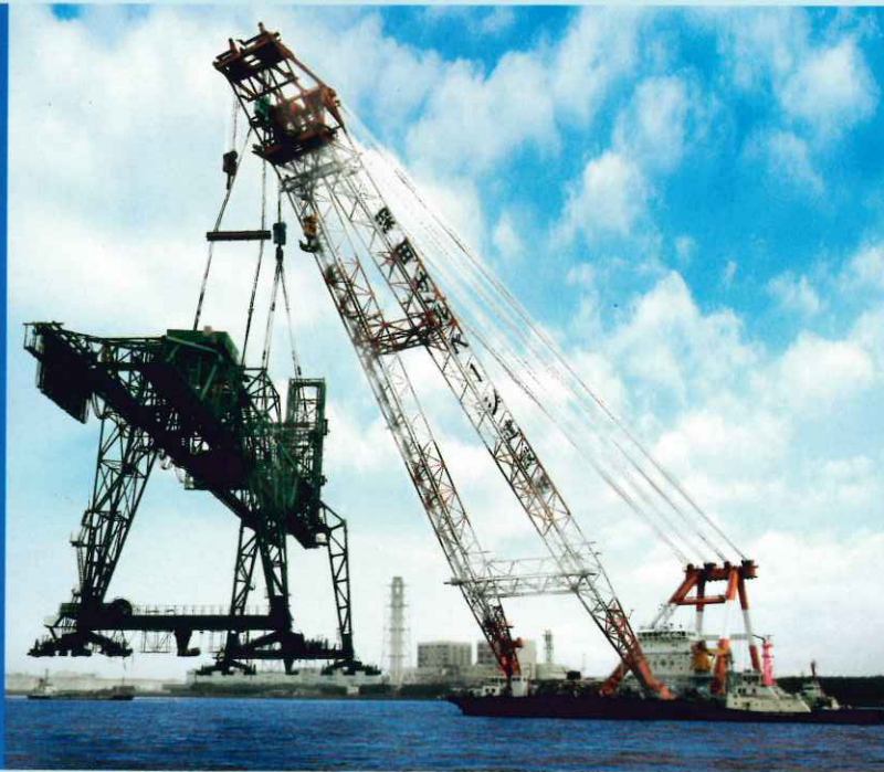
川崎支店 大型荷役機械設置工事 (平成20年10月稼働開始)
